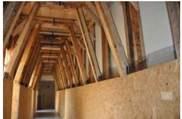
Un corridoio del Convitto Tulliano con le strutture provvisorie di sostegno
